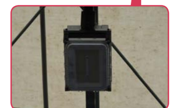
天井に設置したLED照明
